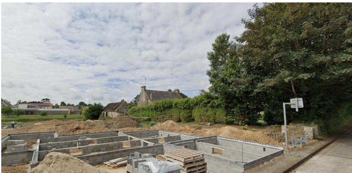
Vue depuis la future voie d'accès au Nord du site
