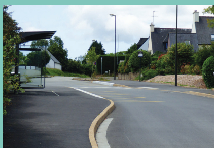
Réfection des voiries et trottoirs : 65 000 €.
