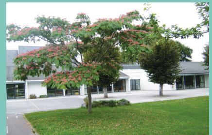
Réhabilitation du groupe scolaire Lucie Aubrac : 132 000 € (dont 24 000 € de subvention assurée. Autre demande de subvention en cours). Huisseries, toiture, isolation et fours et armoire froide de la cantine.
