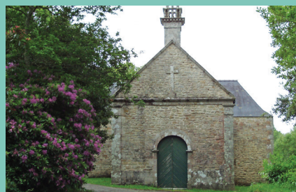
Réhabilitation de la chapelle St Philibert ; 30 000 € (demande de subvention en cours). Nouvelles portes et gouttières.
