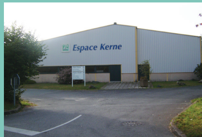
Réfection de l'espace Kerne (2 e tranche) : 420 000 € (dont 70 000 € de subvention obtenue. Autre demande de subvention en cours). Toiture, isolation, réaménagement intérieur et rénovation du sol de la salle socio.
